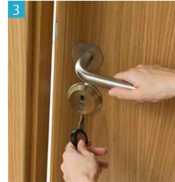
3 Mit Einstecken dieses Schlüssels in den Zylinder einer betreffenden Tür werden die neuen Zutrittsberechtigungen übertragen. Der verlorene Schlüssel kann an diesem Zylinder nicht mehr schließen, alle anderen berechtigten Schlüssel haben weiterhin freien Zutritt.
